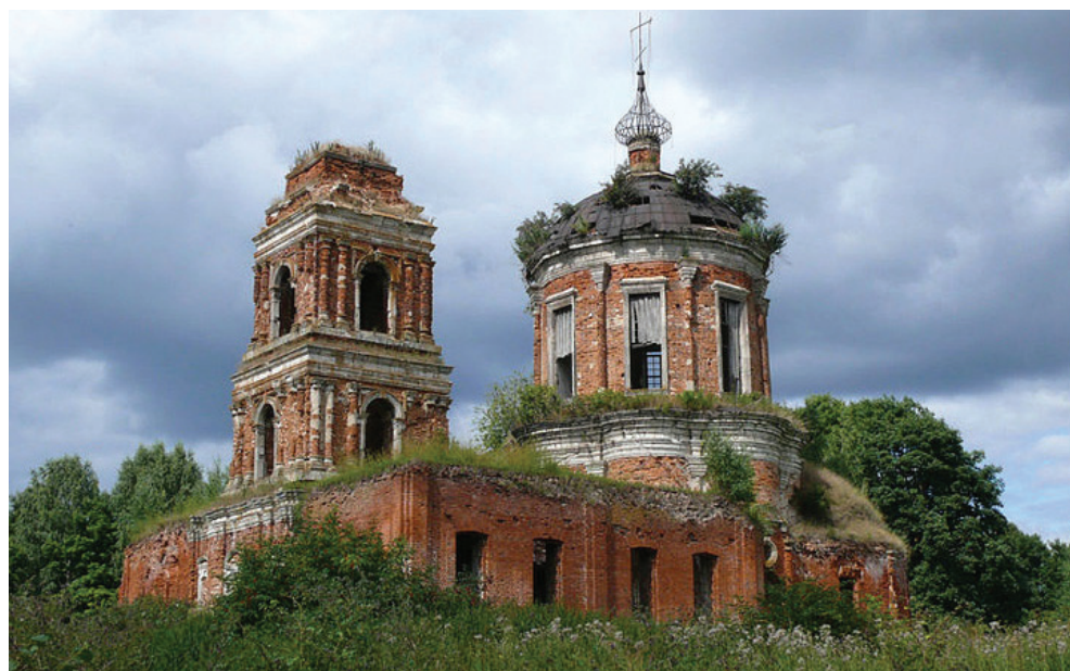
Полуразрушенная Никольская церковь в селе Руднево Тульской области, строительство которой начал С.Л. Игнатъев. Памятник архитектуры. Охраняется государством
