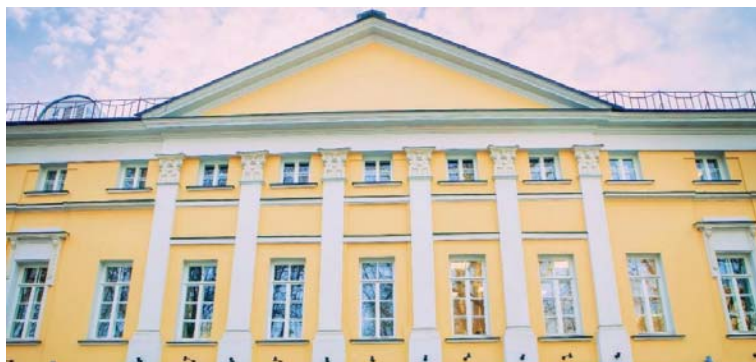
Здание ИЗиСП, г. Москва, Б. Харитоньевский пер. д. 22/24
