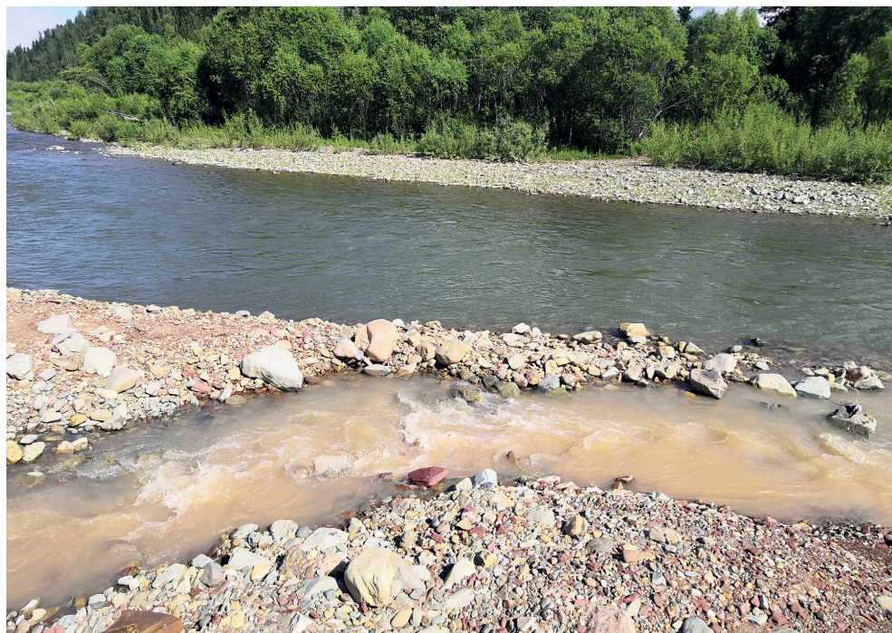
Образовавшийся прорыв дамбы отстойника, место впадения воды из отстойника в реку Каурчак
