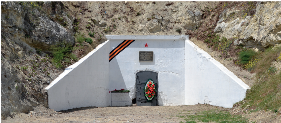
После завершения работ
