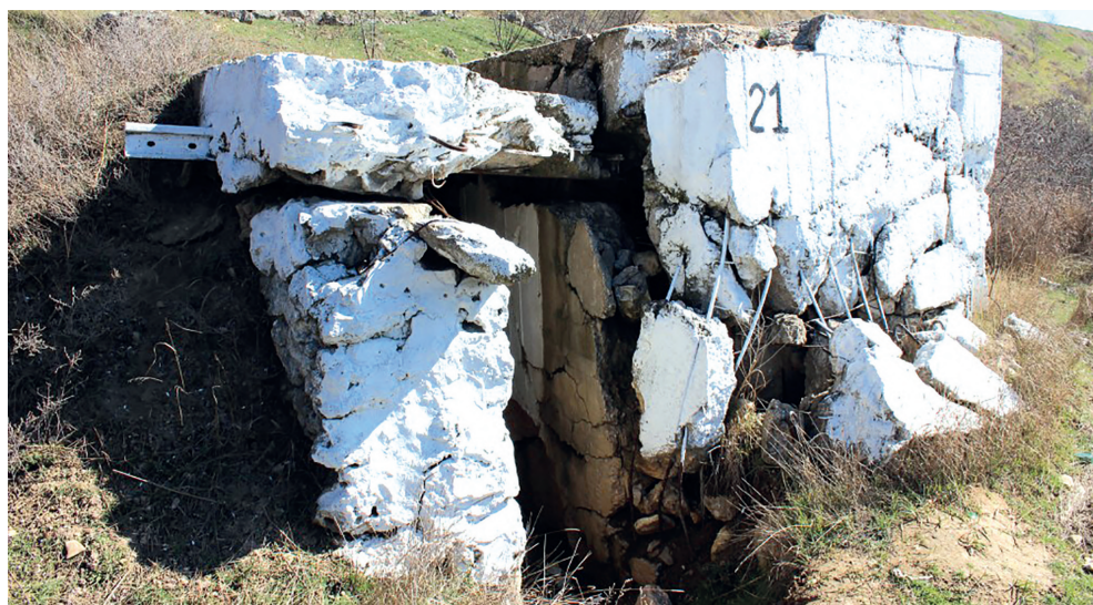
ДОТ № 21 (до начала работ)
